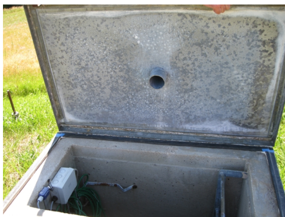
Lugen slutter tæt og er beskyttet mod indtrængen af smådyr.
